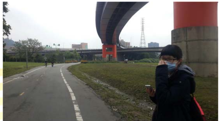
水源區自行車道勘查
