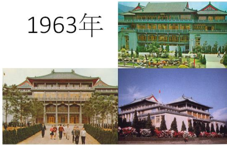
大成館：1963(民國52年)落成，為本校第一棟館樓。
