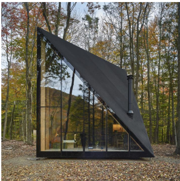
圖 4：建築師 Bjarke Ingels Group (BIG) 的五面體微形建築作品「Klein A45」，建築面積 17 平方公尺，在場地進行模組組裝，均由 100% 可回收材料組成。
