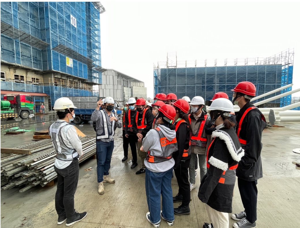
臺北市南港機廠社會住宅工地現場參訪
